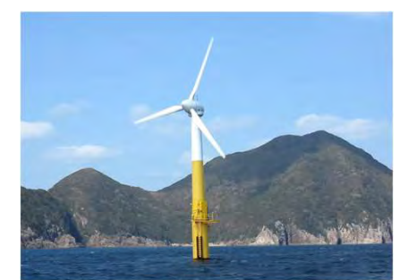
2MW実機の1/2モデル 実海域実証試験
