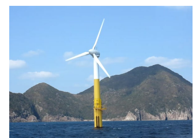
2MW実機の1/2モデル 実海域実証試験
