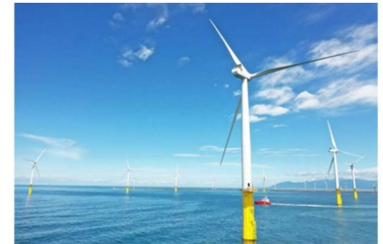
引用：秋田洋上風力発電株式会社ホームページより
